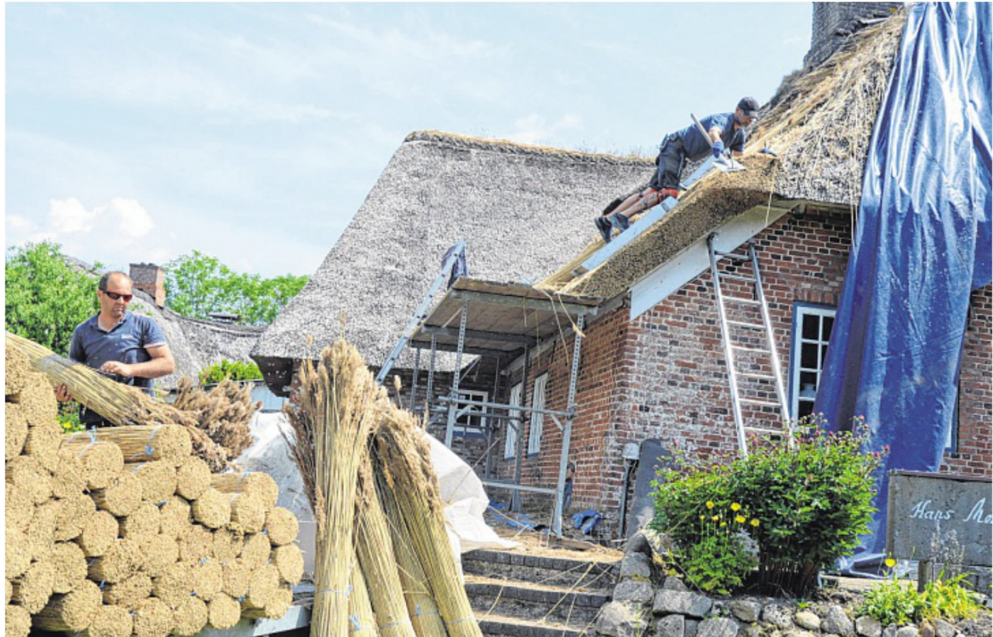
Das Hans-Momsen-Haus wird derzeit mit einem neuen Reetdach versehen.
