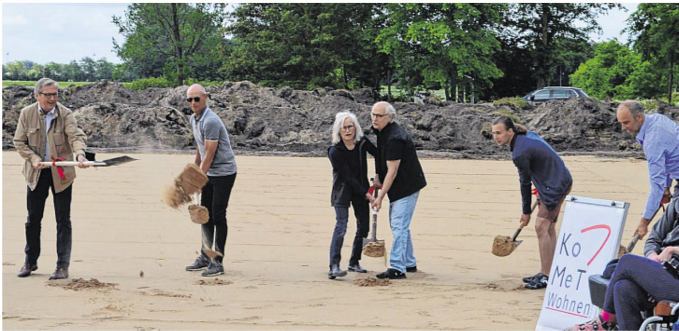
Zum Baustart kamen viele, die das „Haus Komet“ seit zehn Jahren mit geplant und unterstützt haben.
