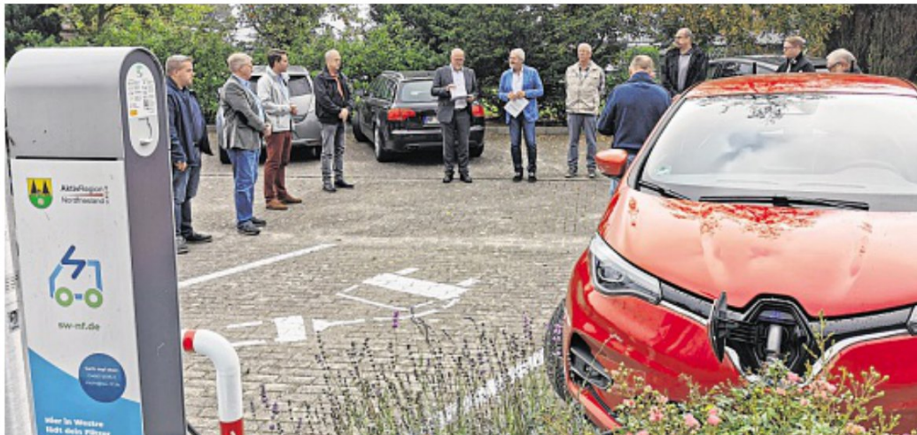
Vertreter der beteiligten Kommunen, der Stadtwerke Nordfriesland, des Amtes Südtondern und der Aktiv-Region bei der Einweihung der Ladesäulen in Westre.
